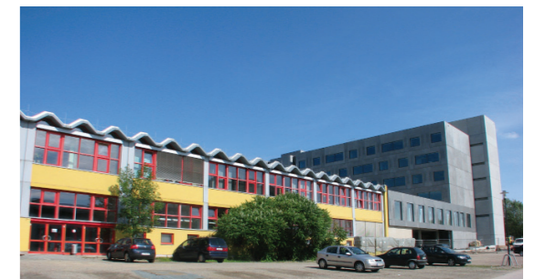
Der Reinraum 1 des ZfM befindet sich in Halle H neben dem Weinholdbau auf dem Smart Systems Campus Chemnitz.
