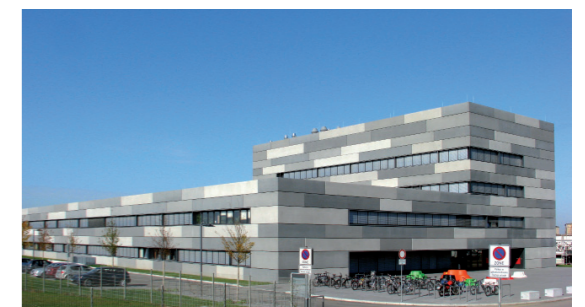
Der Reinraum 2 des ZfM befindet sich im Institut für Physik der TU Chemnitz auf dem Smart Systems Campus Chemnitz.
